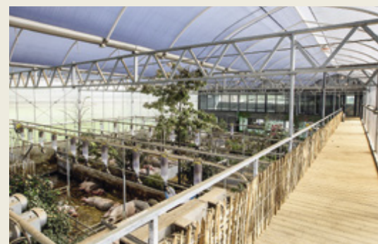
Im Dachraum des Vorführstalles der Familie Noordman ist ein Besuchergang angelegt. Details ab Seite 50.
